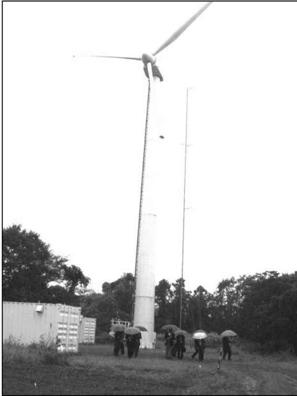
風力発電システム
